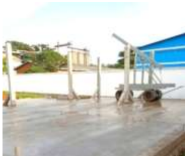
Grue manuelle posant les colonnes sur la dalle de sol.
