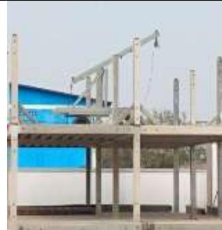
Grue Manuelle soulevant des poteaux et des poutres du sol pour les poser au 2 ème niveau.
